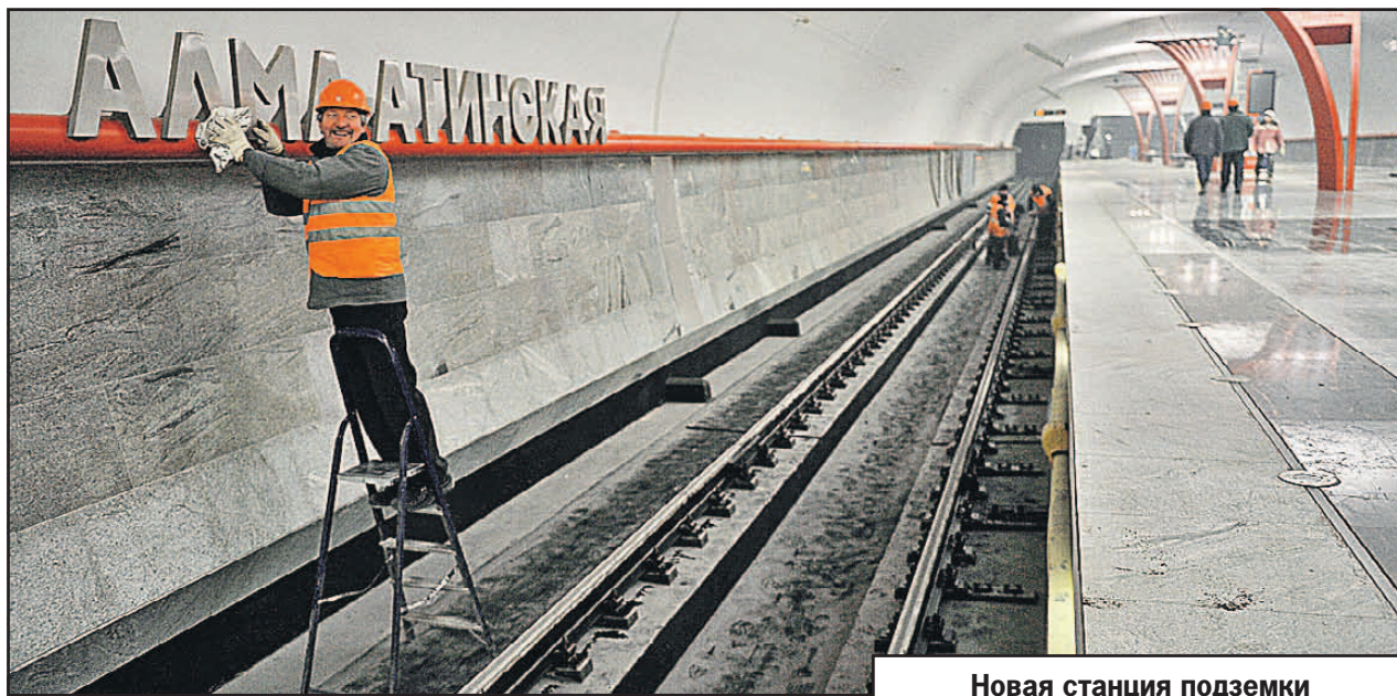
Новая станция подземки выполнена в стиле хай-тек.
