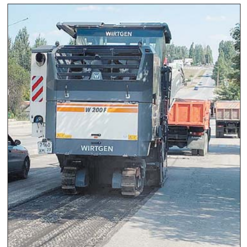
Сначала заменят асфальт, затем возьмутся за трубы.
