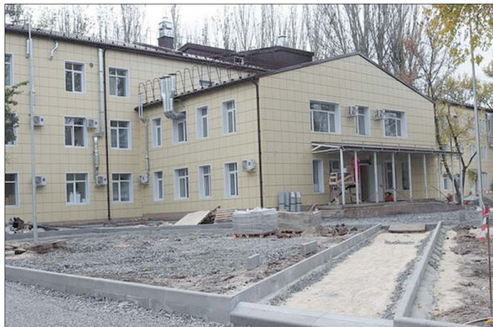
После ремонта детская больница выглядит красиво, но не выполняет свои функции.
