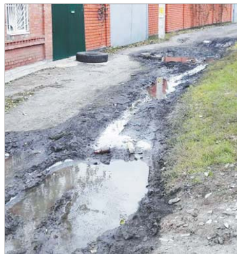
До ремонта на проезде текли ручьи.
