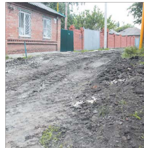
Сегодня жители пр.Фрунзе, наконец, добились ремонта водопровода.
