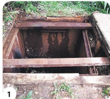
1 Выкапываем яму и вставляем внутрь сварной металлический короб
