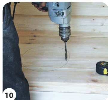
10 Прорезаем отверстие в деревянной ступеньке
