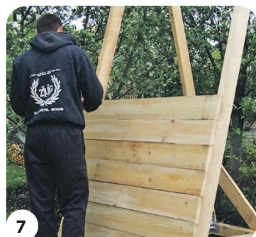
7 Зашиваем стены досками
