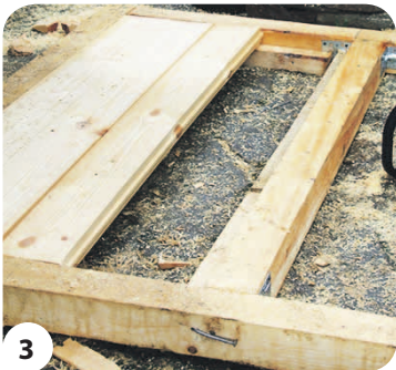
3 Крепим доски пола на основание
