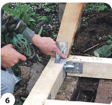
6 Крепим стойки с помощью металлических уголков
