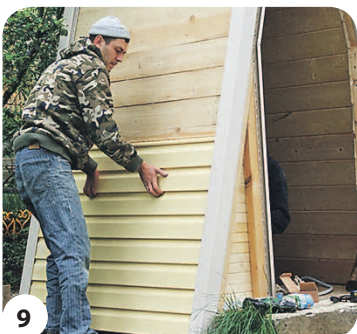
9 Монтируем сайдинг на стены туалета
