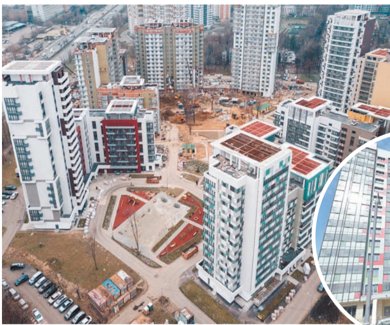
Дома проверяют сверху донизу - поэтажно и поэтапно.
